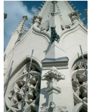
Turmdetail nach Sanierung
